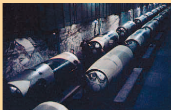
Réservoirs de fusées V2 sur la chaîne de montage (photo SS).
